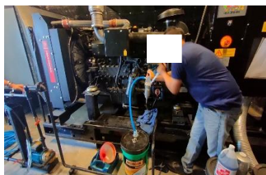
ภาพที่ 2-23 การตรวจเช็คเครื่องกำเนิดไฟฟ้า
