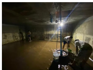
ภาพที่ 2-22 (ต่อ) การทำความสะอาดถังเก็บน้ำใต้ดินและตรวจสอบการรั่วไหล
