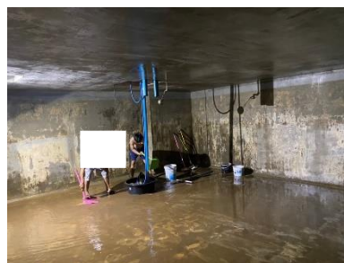
ภาพที่ 2-22 การทำความสะอาดถังเก็บน้ำใต้ดินและ ตรวจสอบการรั่วไหล
